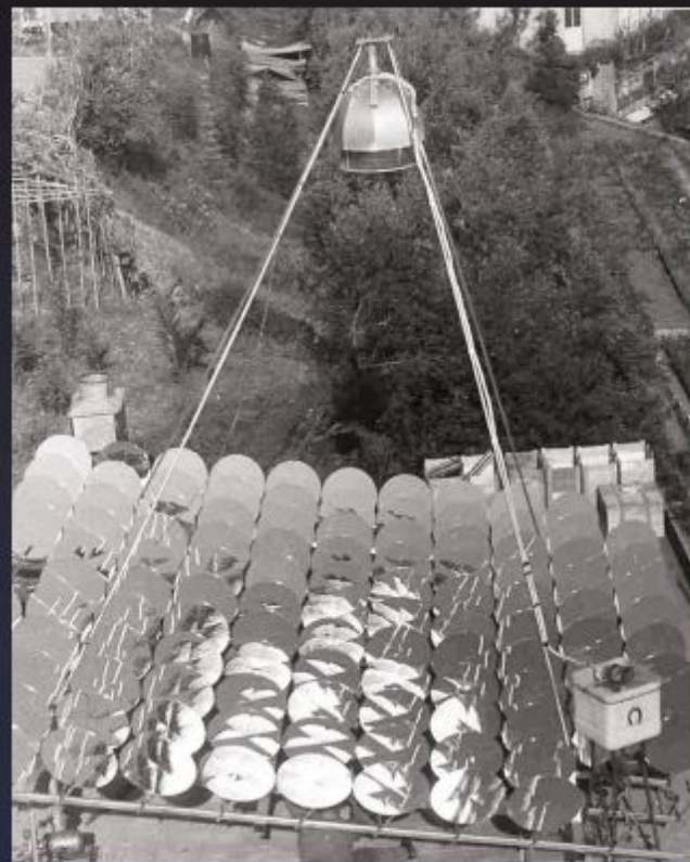
S. Ilario (Genova) 1965 - Impianto solare a concentrazione puntuale fresnel.
