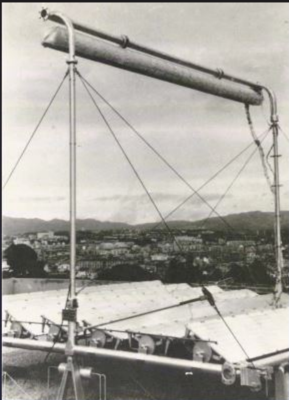
Marsiglia (Francia) 1963 - Impianto solare a concentrazione lineare fresnel.
